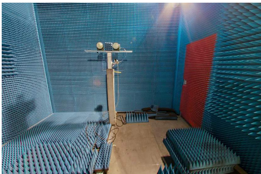
Chambre anéchoïque électromagnétique, du département GEII
